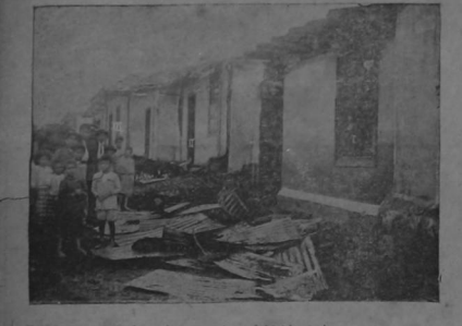
Estado en que quedaron las cosas después del incendio. I.—Casa habitada por Adelino González y familia, en la cual principió el fuego. II.—Casa de la señora Dionisio Benillo. III.—Casa de don Víctor Borillo, que habitaban So o Borges y familia.
